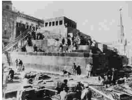
Construction du mausolée
