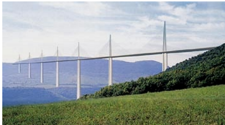
Viaduc de Millau
