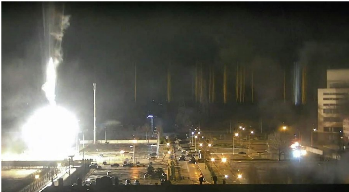
Pseudo bombardement...? d'un bâtiment administratif sur la centrale de Zaporizhzhia?
