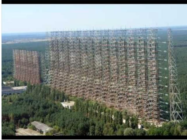
Antennes du Duga-1 près de Tchernobyl. L'ensemble de cages coniques sur la droite représente les directeurs alimentés par une ligne symétrique. On aperçoit au centre gauche les fils constituant le réflecteur.
