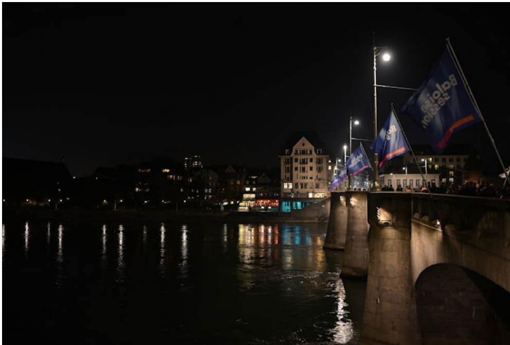
– Le Mittlere Brücke sur le Rhin – Bâle/Basel –
