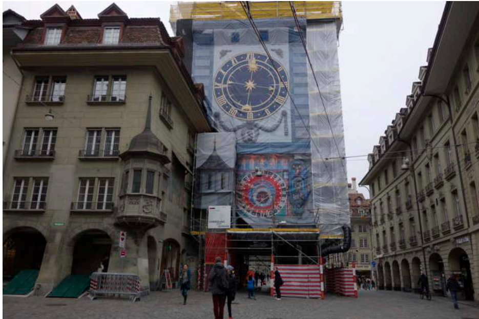
— Tour de l'horloge en cours de restauration — Bern/Berne —
