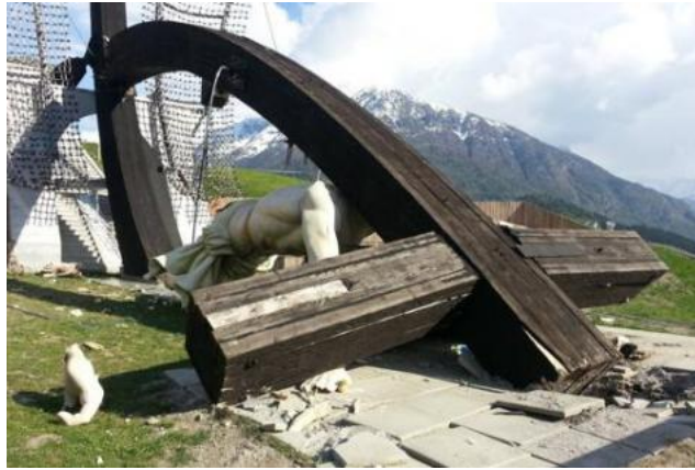
La croix du Christ Rédempteur après son effondrement
